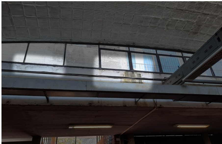
Figura 17: Cerramientos metálicos corroídos aportan al deterioro de elementos estructurales contiguos.
