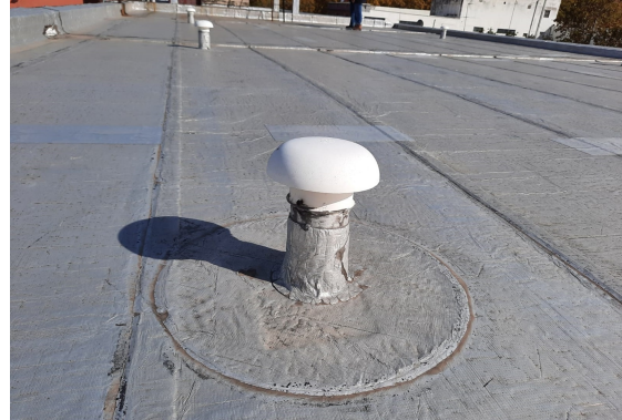
Figura 19: Pase en losa (muy probablemente imprevisto inicialmente).
