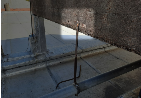
Figura 18: Uso del tanque como estructura de soporte para tubería.
